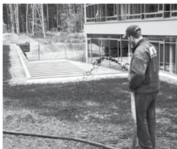
Die ZinCo Anspritzbegrünung ist rationell für grosse Flächen – sie bringt in einem Arbeitsgang Mulch- und Trägermaterial, Kleber, Nährstoffkomponenten sowie Saatgut auf. Die Vegetationstragschicht wird oberseits erosionssicher fixiert. Ebenso das Saatgut oder/und Sedum-Sprossen.
